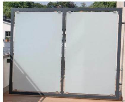
Das Sichtschutzelement der direkt nebeneinanderliegenden Balkone wird als pulverbeschichtete Stahlkonstruktion (Höhe ca. 1,80 m) mit endbehandelten Oberflächen wie die Geländer ausgeführt. Sie erhält eine innenliegende Füllung aus undurchsichtigem Panel (Fabrikat Trespa Meteon oder glw.) gemäß Farbkonzept des Architekten.
